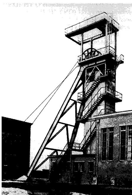
Afb. 69. schachtbok, schachttoren
